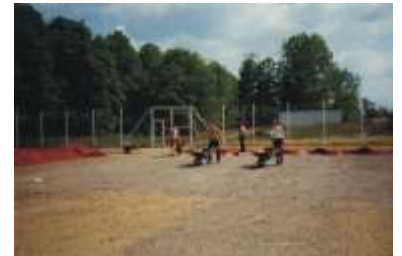
> Vor dem Vergnügen die harte Arbeit. Platzarbeiten 86/87
